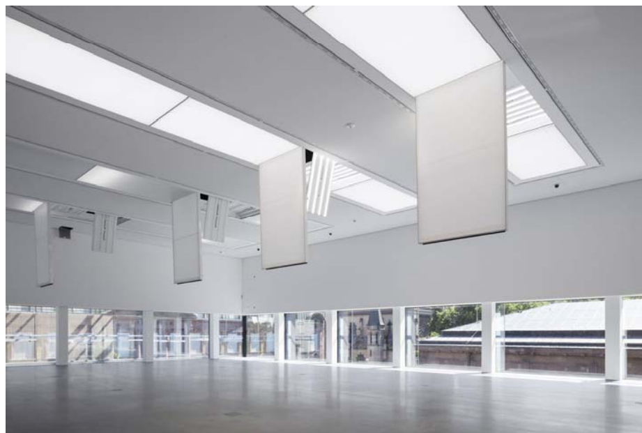
Nem csupán maga a világítási rendszer, hanem az álmennyezetbe felszerelt épületgépészeti rendszerek is könnyen hozzáférhetők karbantartási célokból. A föliázott keret és a LED-eket tartalmazó szerelőlap úgy lett felfüggesztve, hogy szabaddá tegye az ellenőrző nyílást. – Fotó: HGEsch Photography
